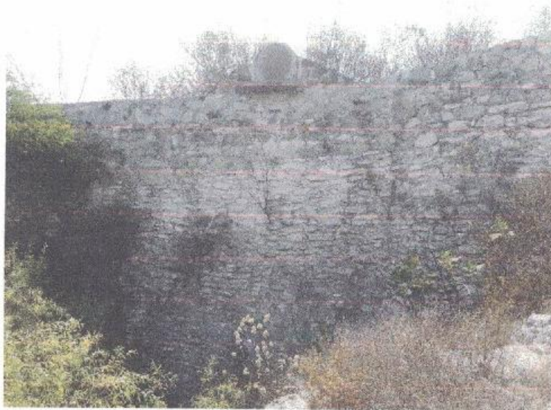
Figura 23. La piedra blanca se utiliza también para la construcción de muros de retención de tierra.
